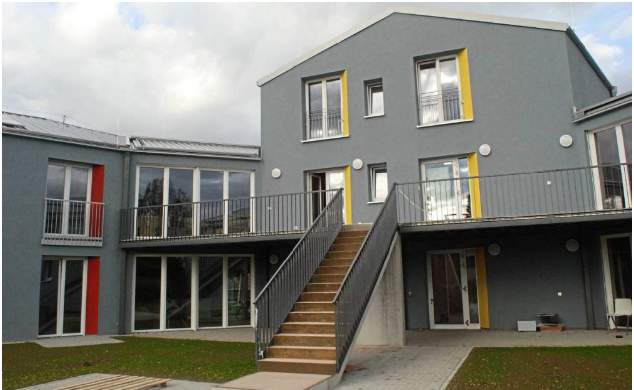
Der Gebäudekomplex in Bühl liegt neben der Weststadtgrundschule und somit auch nah am Stadtzentrum – die Lage ist für die Lebenshilfe und für die Bewohner ideal.
